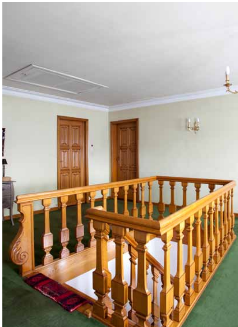
Foto 1 en 2: sierlijke details vragen niet om een andere aanpak dan een egaal oppervlak. Het gebruik van de juiste druk zorgt ervoor dat de sierelementen volledig intact blijven. De afwerkingslaag achteraf zal die details opnieuw accentueren.
