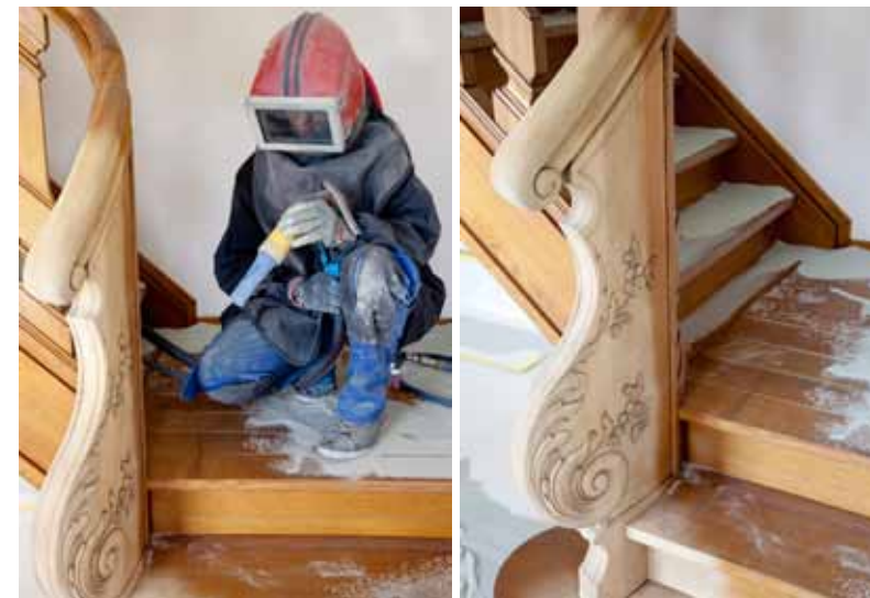
Foto 3: omdat zandstralen zodanig veel stof afgeeft, zijn een beschermend pak en een speciale helm onontbeerlijk. Om toch een helder zicht op het oppervlak te kunnen behouden, wordt er gebruik gemaakt van zeer sterke verlichting, te vergelijken met de verlichting in een voetbalstadion. Foto 4 tot 7: details van dezelfde trap op de andere foto's, maar dan na het zandstralen. De oorspronkelijke kleur van het hout komt opnieuw aan de oppervlakte.
